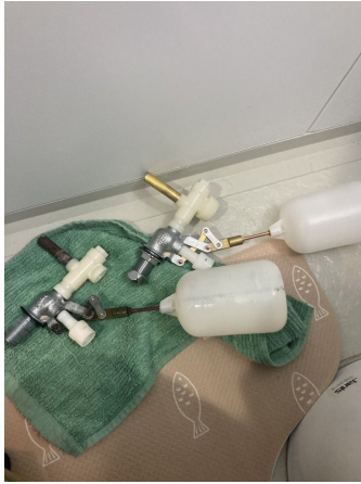
トイレボールタップ取替
